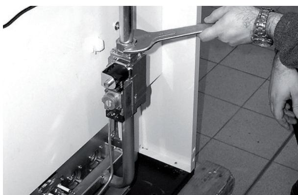
рис. 9 - Открутите гайку крепления газового клапана
