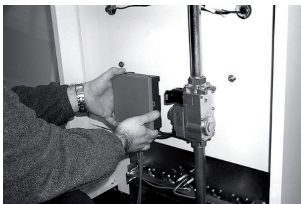
рис. 8 - Снимите блок управления
